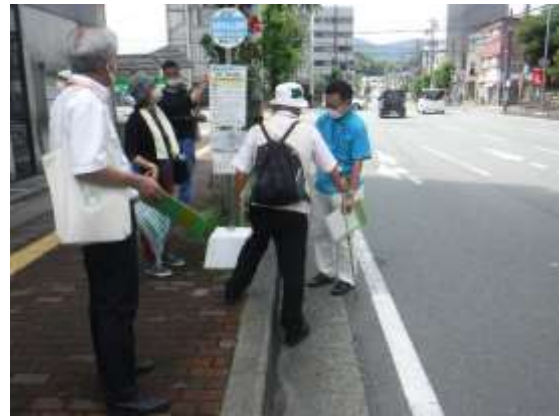
歩道（岡本吹上線：市-6） 歩道と車道の段差が大きい。
